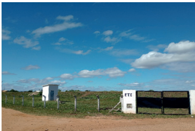
Estação de Tratamento de Esgoto de Mauriti/CE
