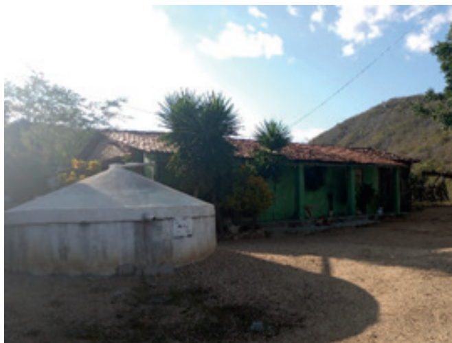
Cisterna para armazenamento de água no Sítio Cacimbinha, Mauriti/CE.
