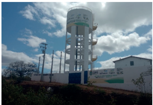
Reservatório elevado em Palestina do Cariri, município de Mauriti/CE
