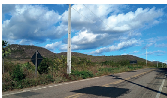
Aspectos do relevo ondulado ao longo da rodovia
