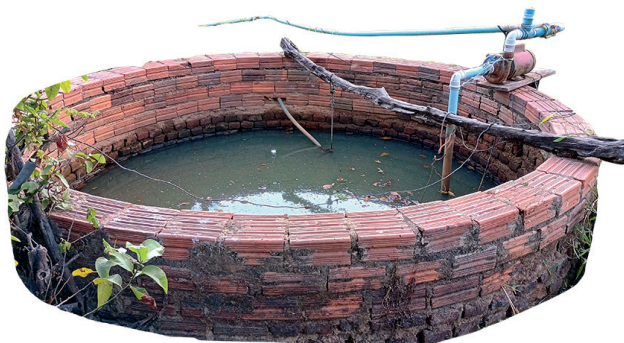
Cacimba com bombeamento Em Açude Velho, Mauriti/CE
